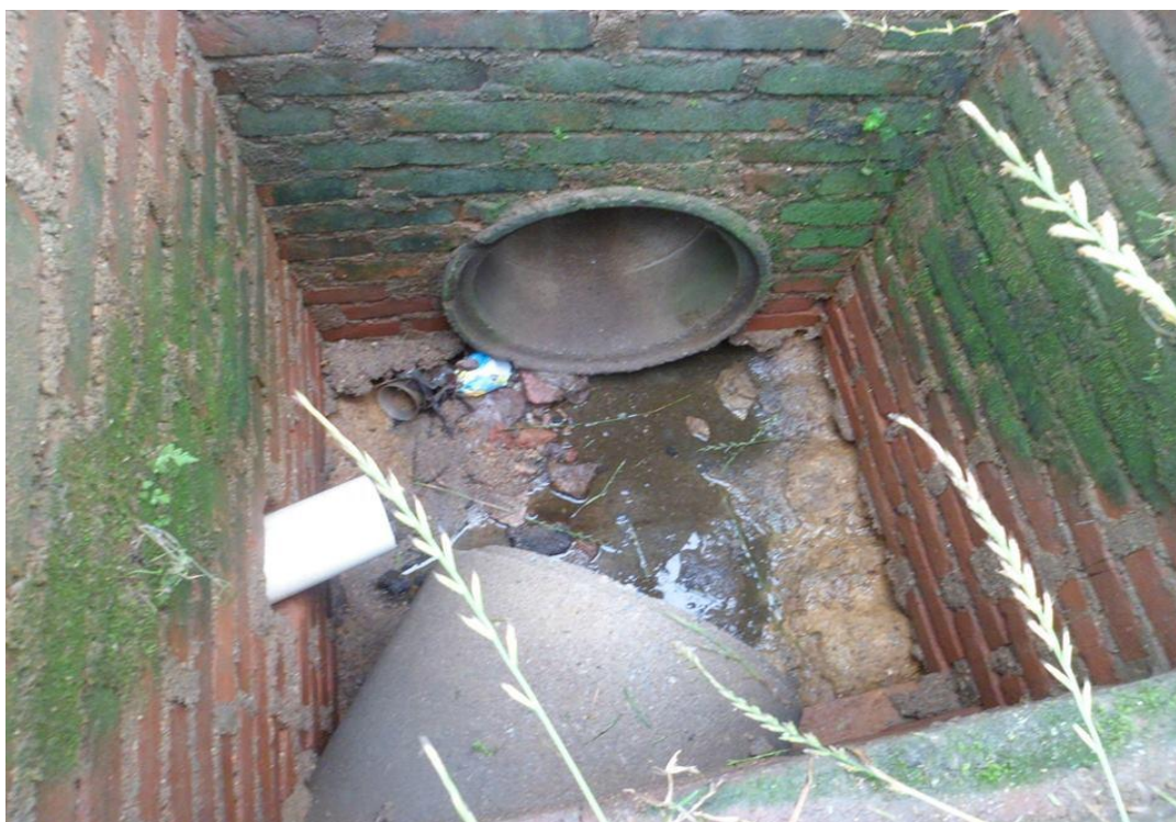
Figura 62 - Foto do sistema de microdrenagem do município de Morro Redondo
