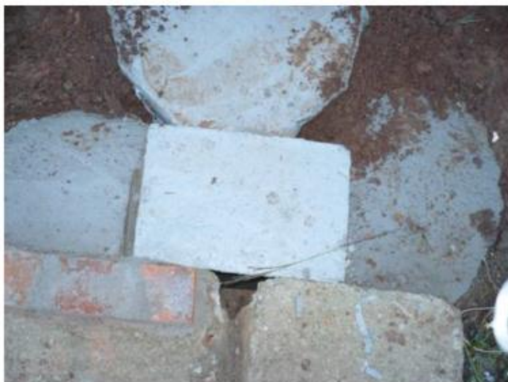
Figura 43 - Sistema de recolhimento do chorume gerado
