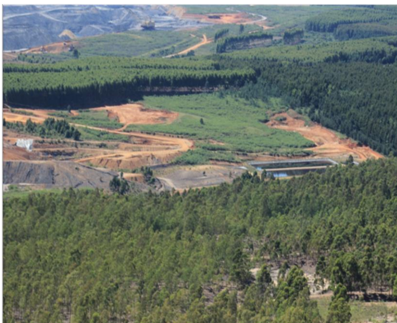
Figura 47 - Vista do aterro sanitário Metade Sul -Candiota-RS.
