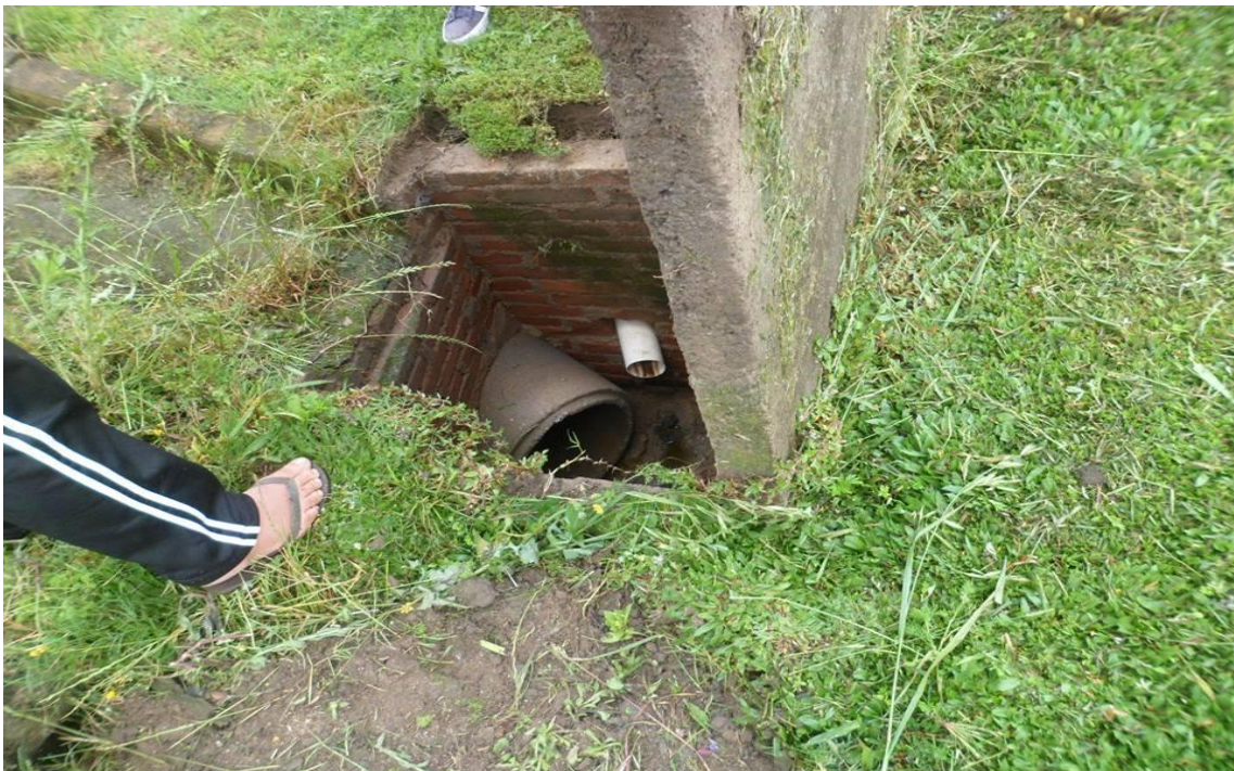
Figura 59 - Foto do sistema de microdrenagem do município de Morro Redondo
