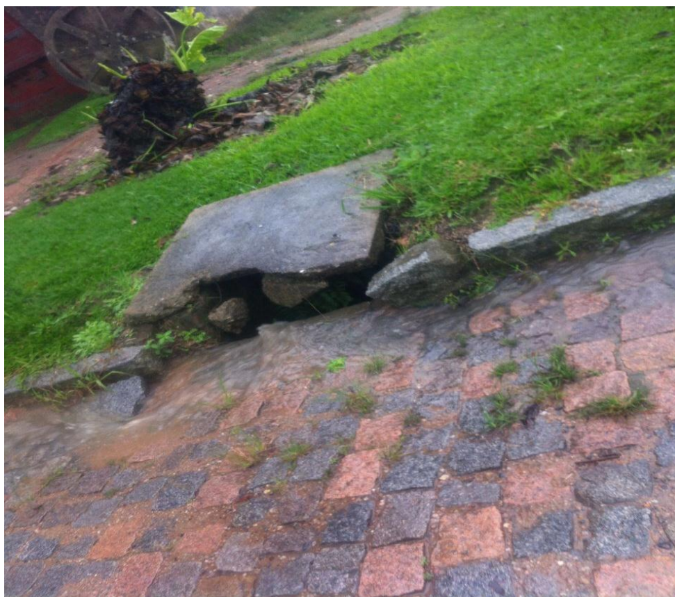
Figura 54 - Foto do sistema de microdrenagem do município de Morro Redondo
