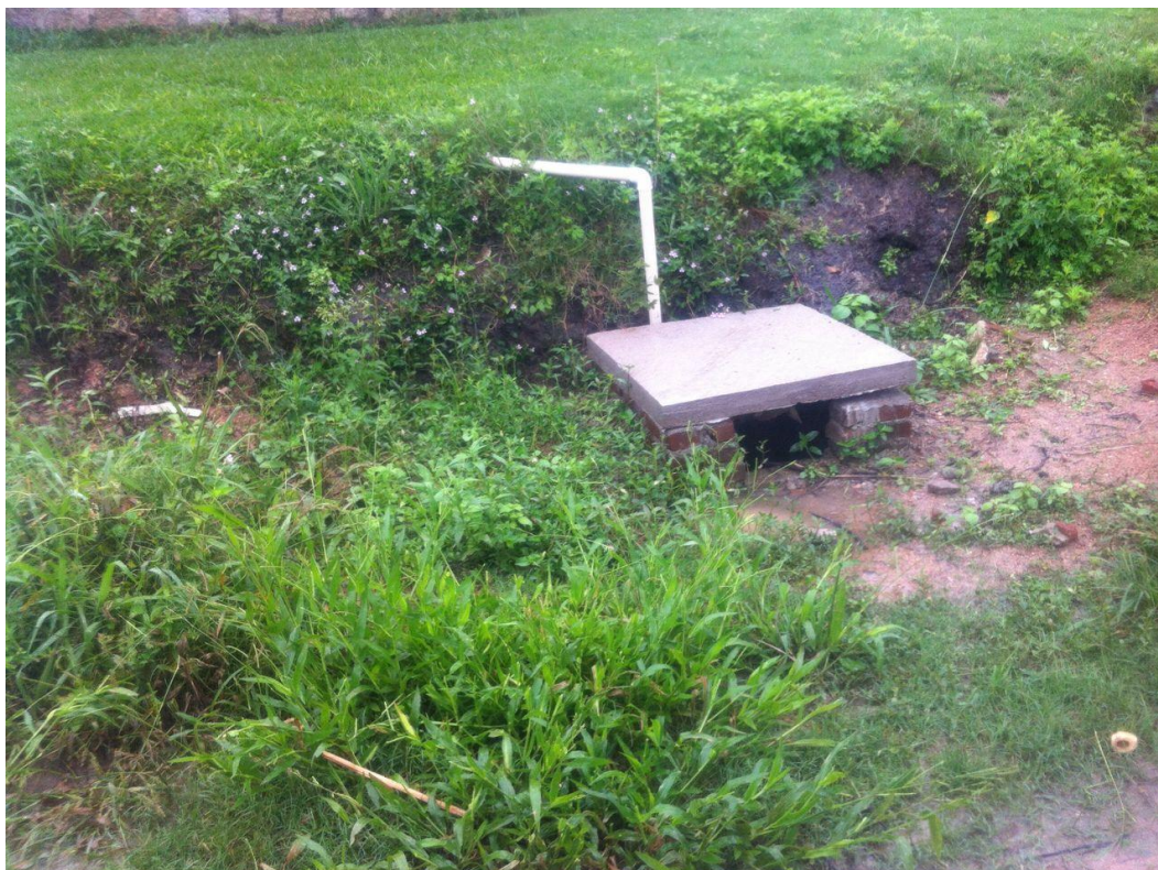
Figura 56 - Foto do sistema de microdrenagem do município de Morro Redondo
