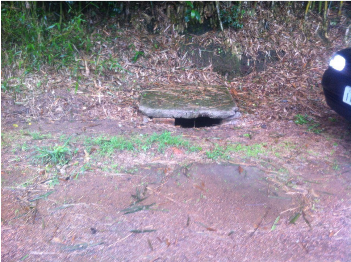
Figura 58 - Foto do sistema de microdrenagem do município de Morro Redondo
