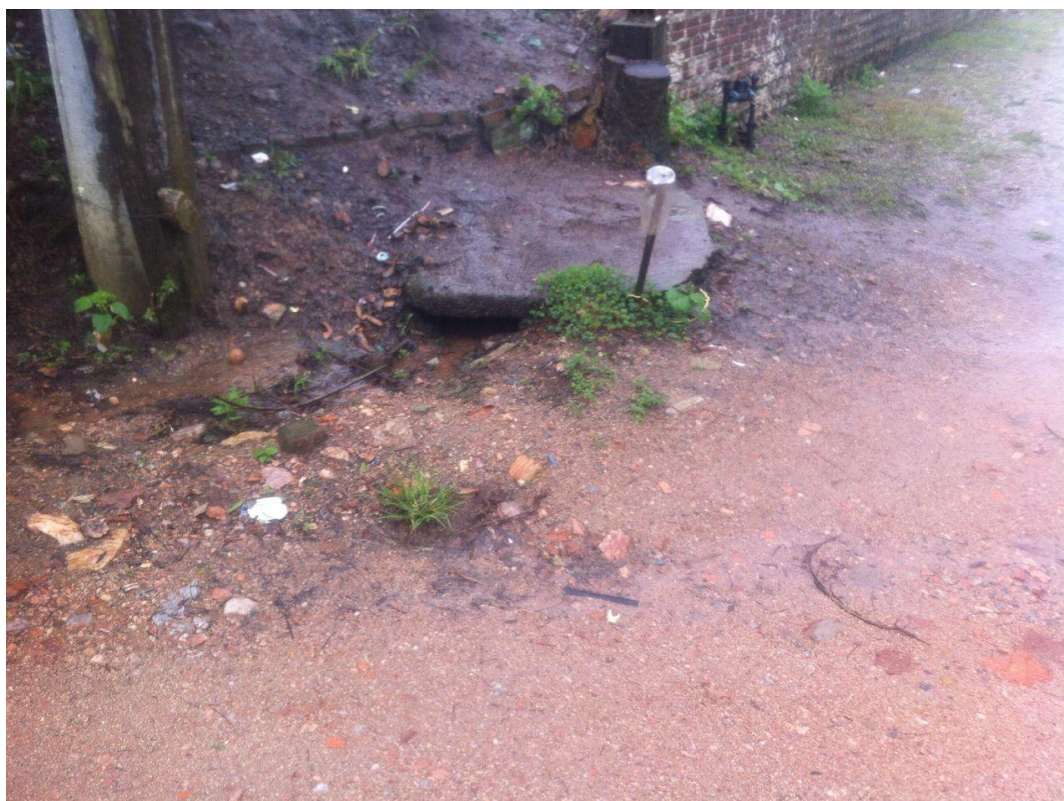
Figura 57 - Foto do sistema de microdrenagem do município de Morro Redondo
