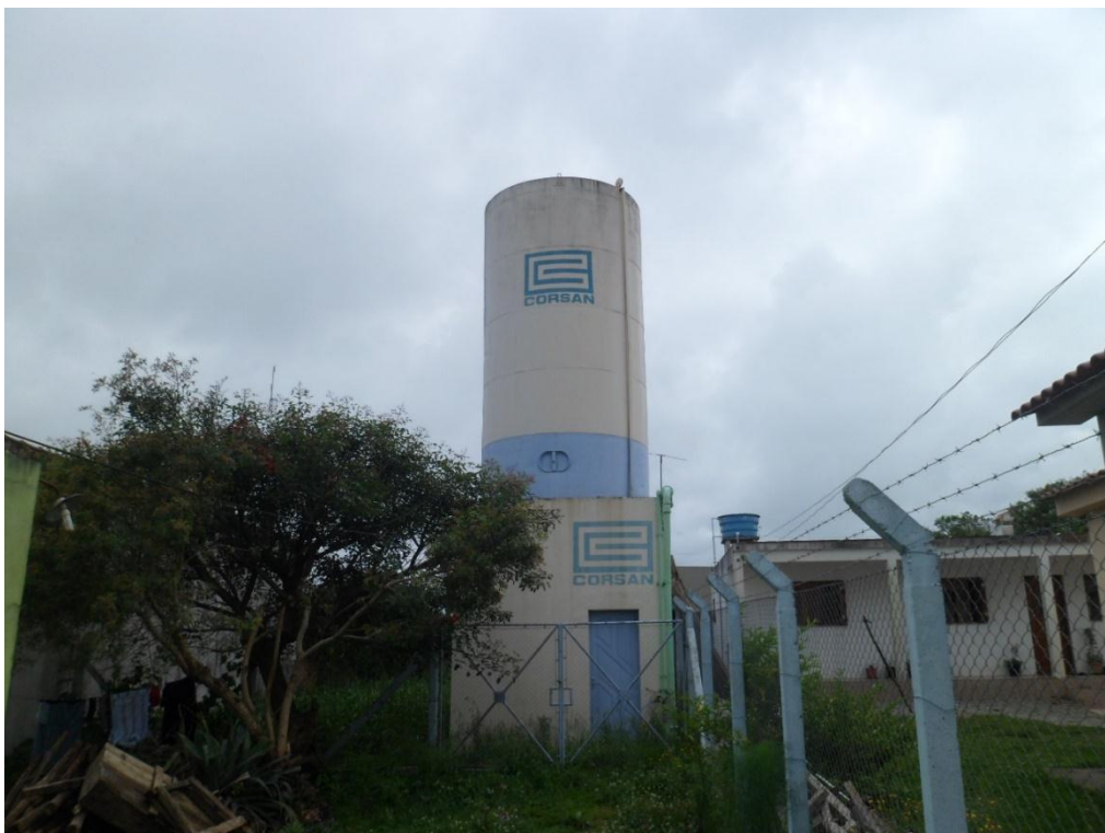
Figura 11 – Reservatório R2 de água de Morro Redondo
