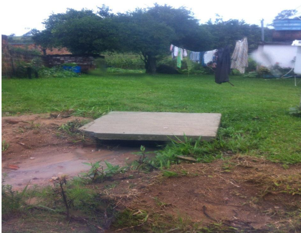
Figura 55 - Foto do sistema de microdrenagem do município de Morro Redondo
