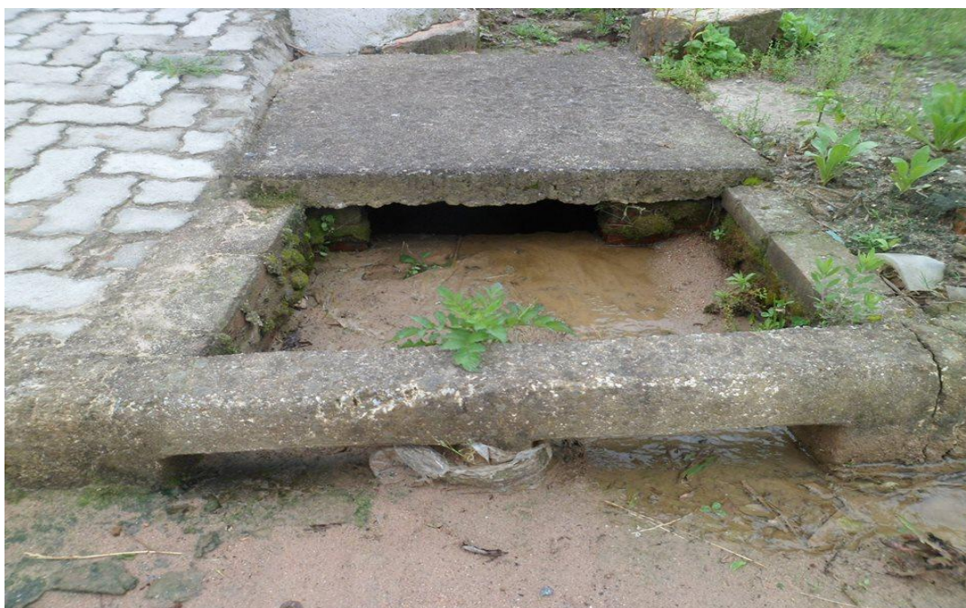
Figura 61 - Foto do sistema de microdrenagem do município de Morro Redondo
